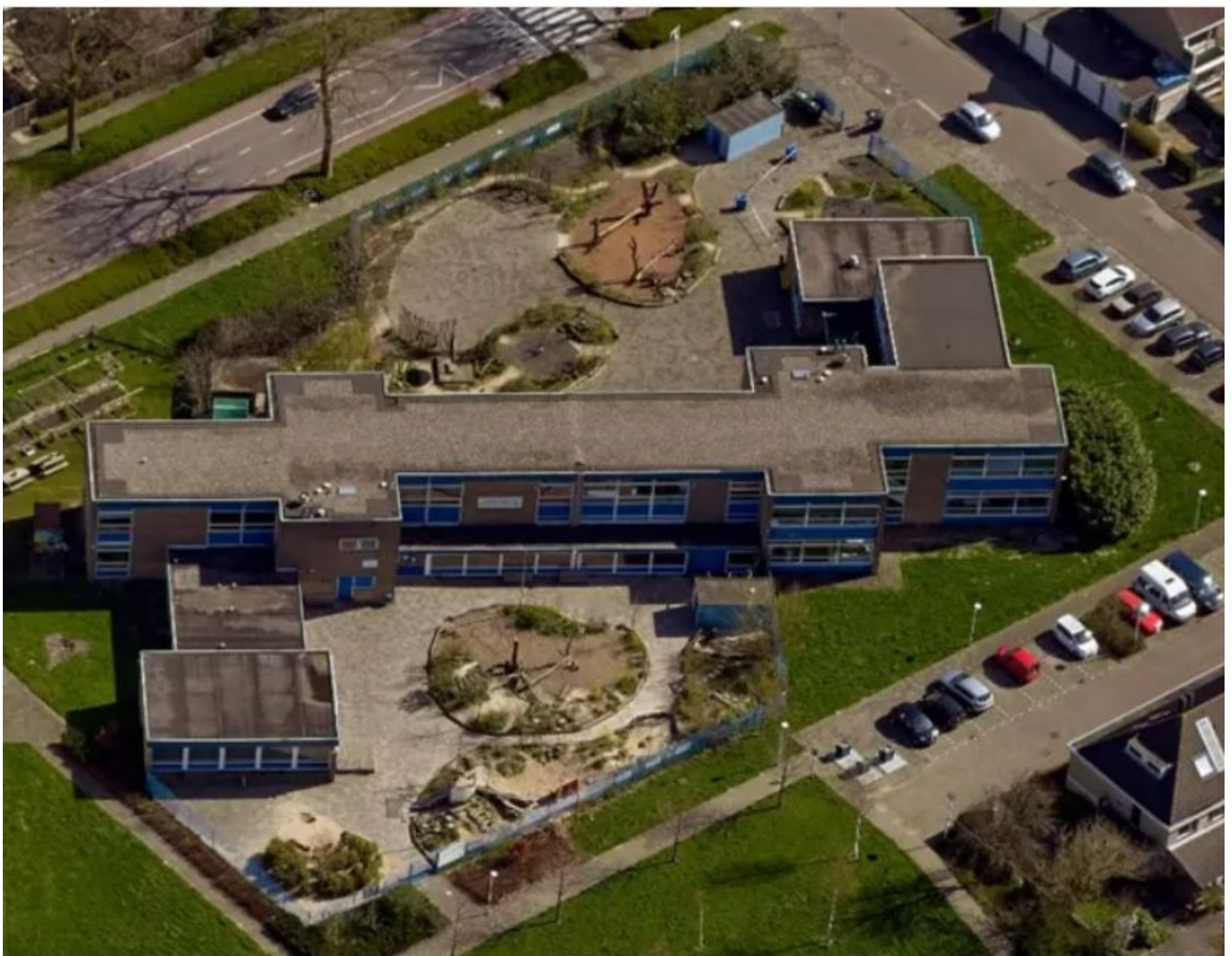
▲ Luchtfoto van het dak van Kindcentrum Ontdekrijk. © BLICK op Onderwijs
